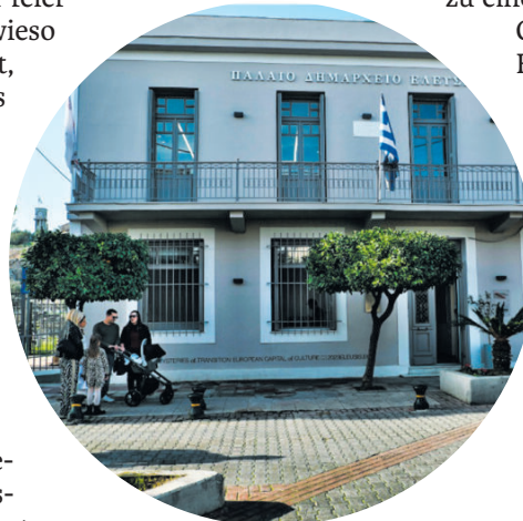
Frisch renoviert: das Rathaus.
